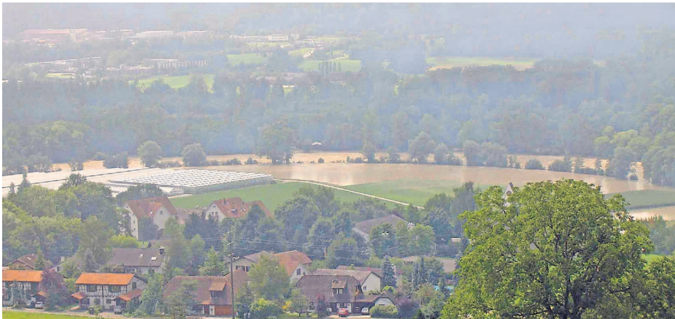
Mehrfach in den letzten Jahren wurde die Reussebene bei Eggenwil überflutet; nach heftigen Regenfällen 1999 und 2007 entstand in den bewohnten Gebieten des Dorfs hoher Sachschaden.
